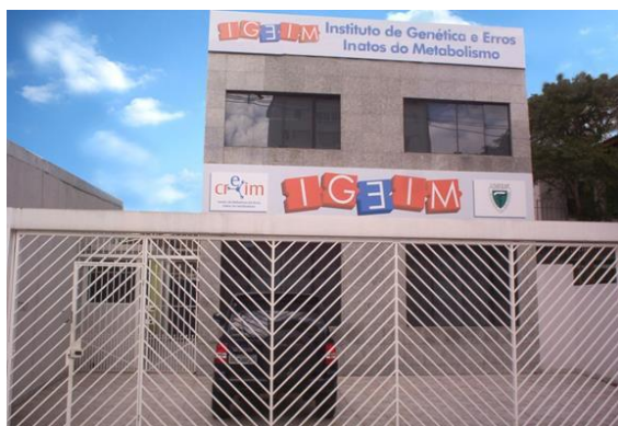
Fig. 1 - Instalações do IGEIM - Entrada
